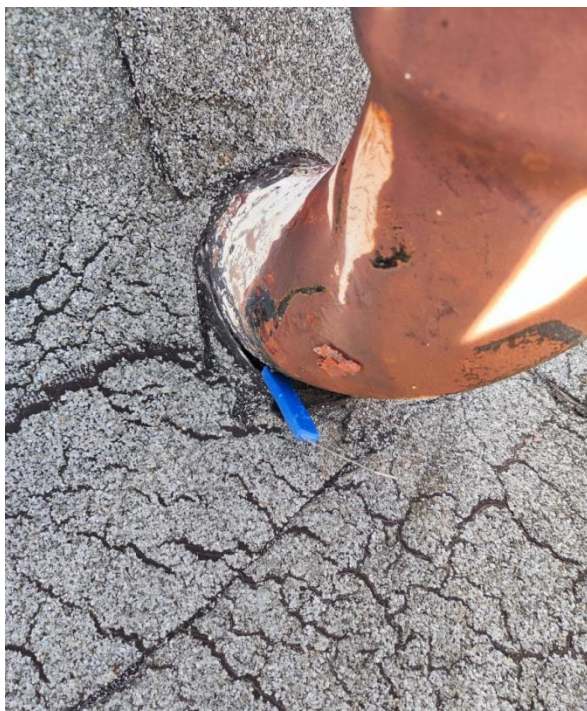
Obrázek č. 6 – Příklad netěsnosti v místě opracování detailů
