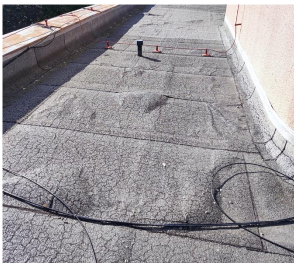
Obrázek č. 4 – Příklad boulení vrchního AP
