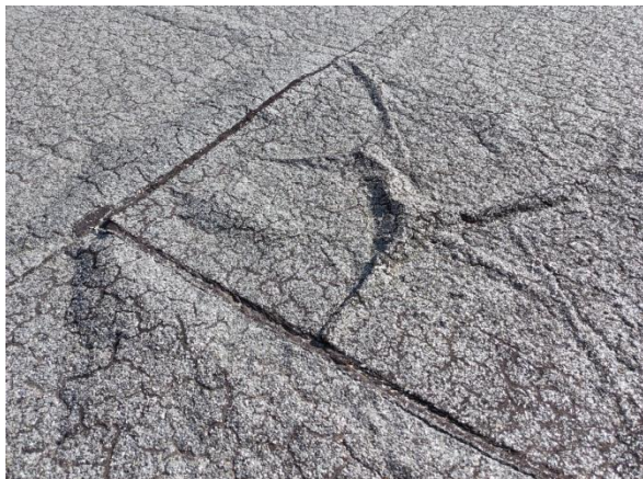
Obrázek č. 1 – Příklad zvlnění povrchu vrchního AP
