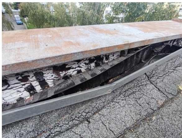
Obrázek č. 7 – Příklad uvolnění vrchního AP v místě atiky
