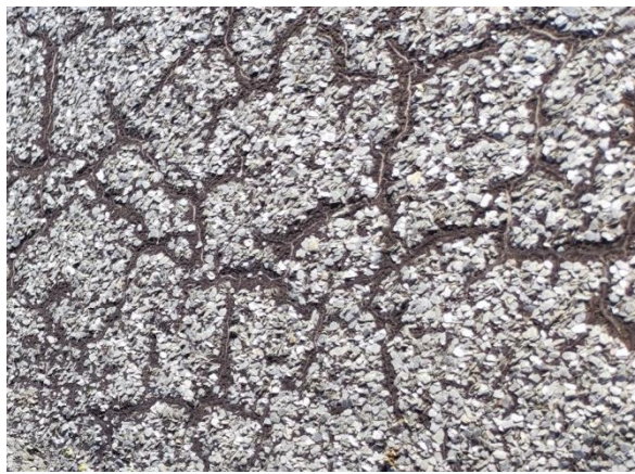
Obrázek č. 3 – Příklad degradace vrchního AP
